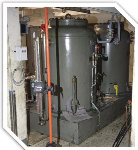
Un système d'intermittence géré par des distributeurs à commande électrique avec des capteurs de pression a été installé de façon provisoire sur l'un des groupes depuis plusieurs mois.
